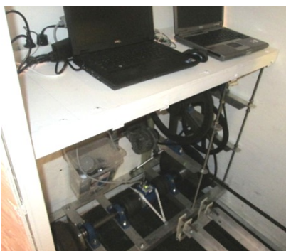
Í mælahúsinu; tölvur og mæliöxull. (Ljóm. Valdimar Össurásson)
